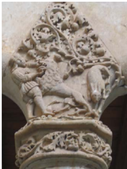
Detalle de un salmer del patio del Palacio de los Condes de Requena
